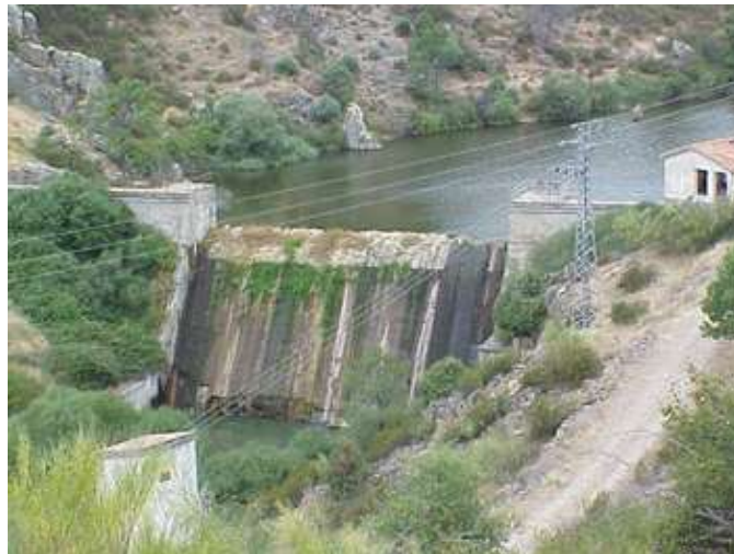
Figure 5. The Robledo de Chavela dam (source: Tajo River Basin Authority – Confederación Hidrográfica del Tajo).
